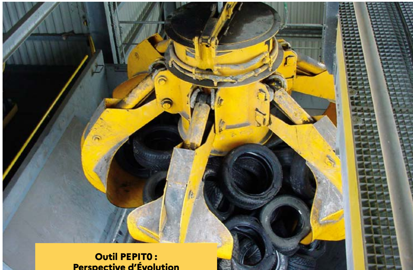
→ Photo de VICAT/Combustibles alternatifs - Stockage pneus entiers-grappin
